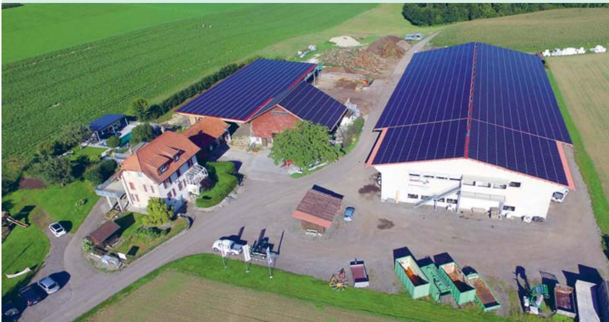
Luftbild des Betriebs santokom.ch in Homburg; gut sichtbar ist die beeindruckende Solaranlage auf 4'500m 2 Dachfläche. Vue aérienne de l'entreprise santokom.ch située à Homburg: on distingue particulièrement bien l'imposante installation photovoltaïque de 4'500m 2 située sur les toits. Bild: Levi Santo
